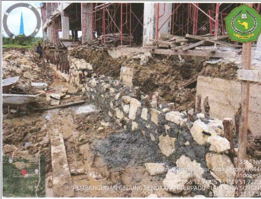
Pekerjaan Pasangan Batu pondasi keliling bangunan
