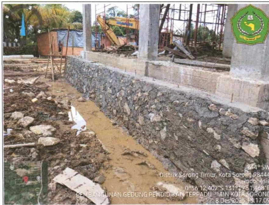
Pekerjaan Pasangan Batu pondasi keliling bangunan
