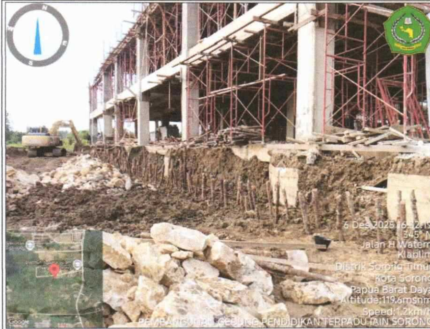
Pekerjaan Pancang Mangi-mangi Pondasi Keliling Bangunan
