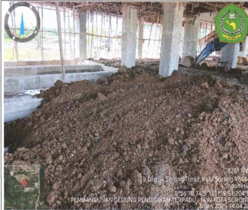
Pekerjaan Timbunan Sirtu dalam bangunan
