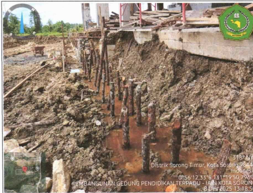
Pekerjaan Pancang Mangi-mangi Pondasi Keliling Bangunan
