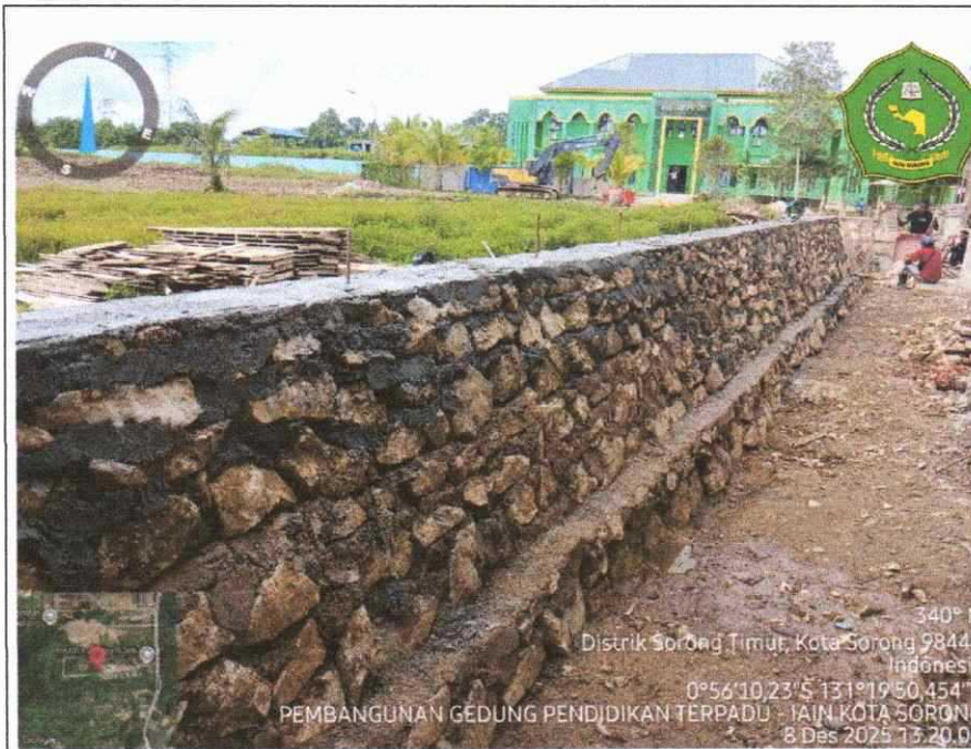
Pekerjaan Pasangan Batu pondasi keliling bangunan
