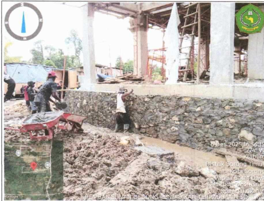
Pekerjaan Pasangan Batu pondasi keliling bangunan
