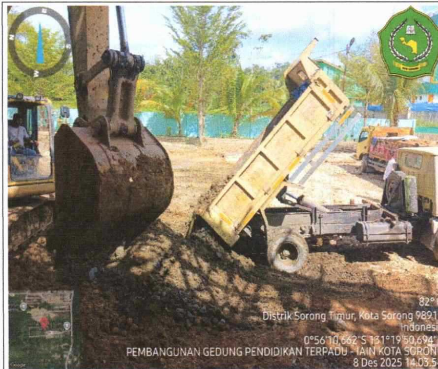
Pekerjaan Timbunan Sirtu Landscape
