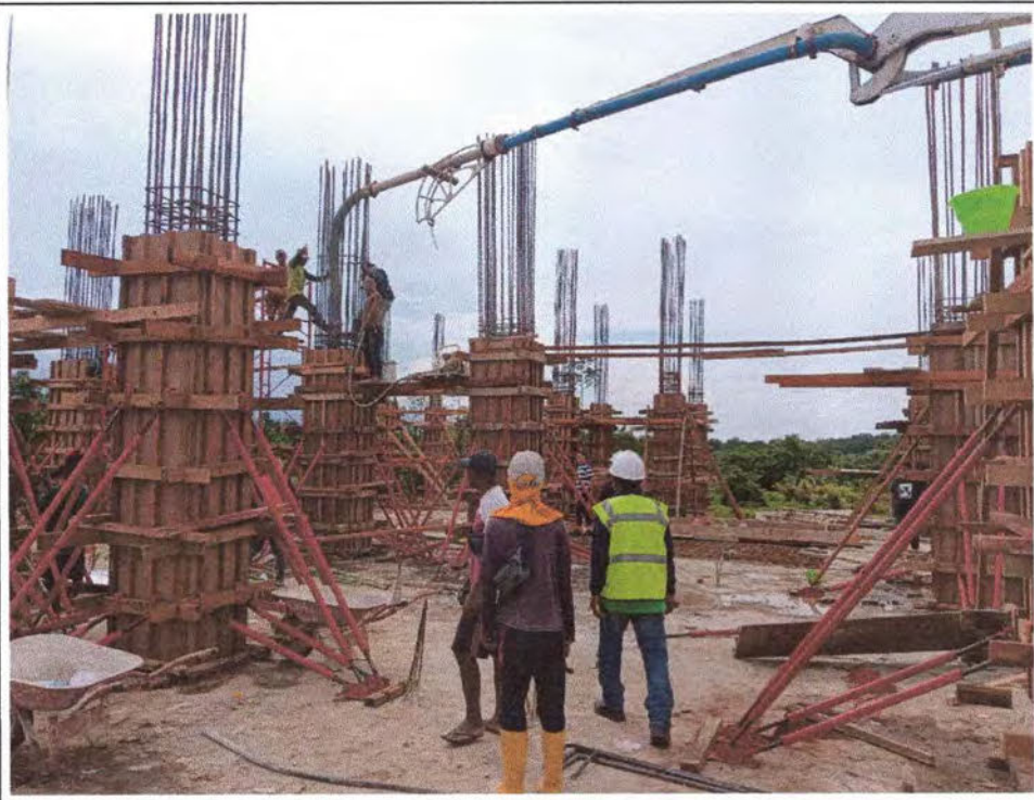
Pekerjaan Pengecoran Kolom
