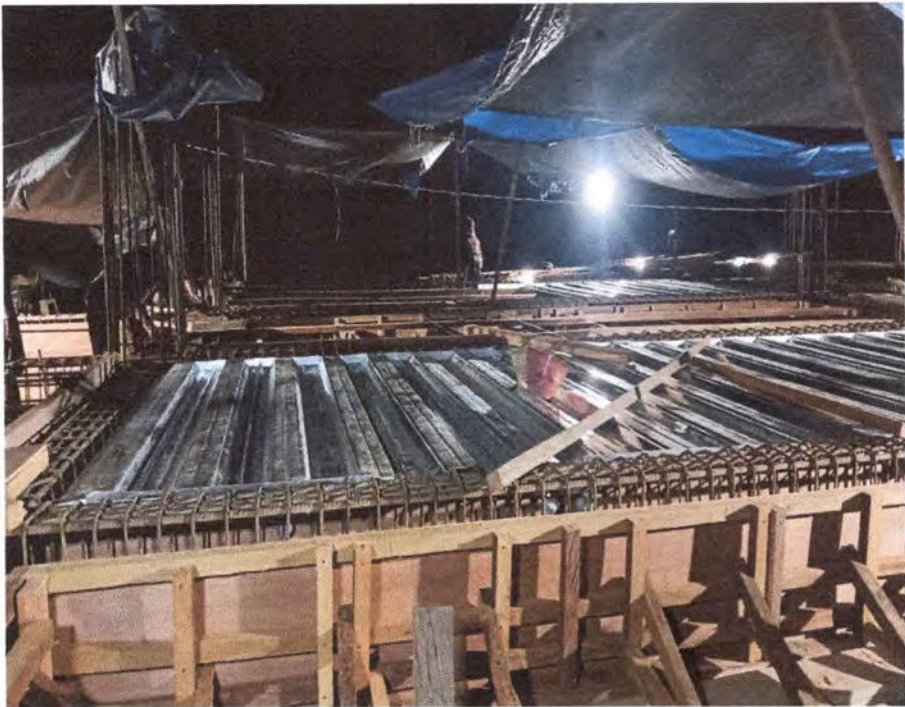
Pekerjaan Pemasangan Tulangan Wiremesh
