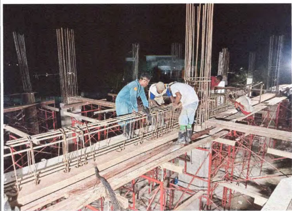
Pekerjaan Pembesian Tulangan Balok
