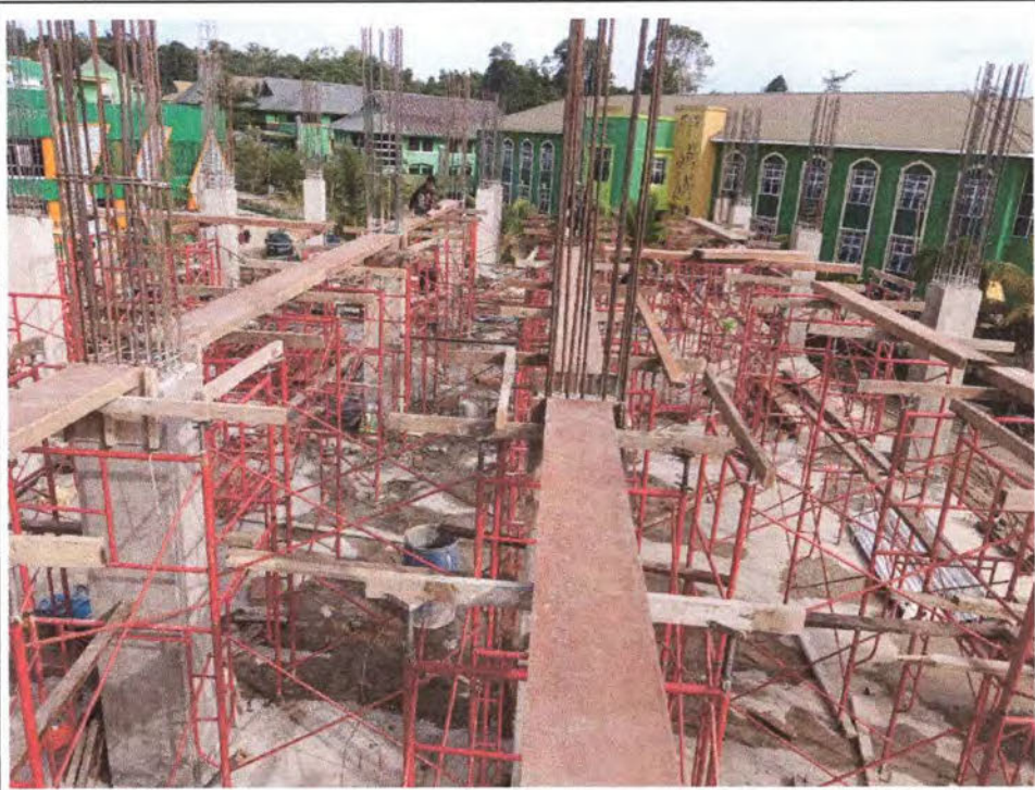
Pekerjaan Pemasangan Bekisitng Balok
