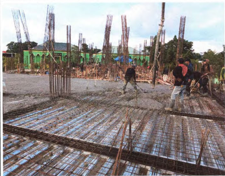
Pekerjaan Pengecoran Balok B1, B2, B3, BA1 ; Plat Floordeck S1 dan S3, Plat Konvensional S2
