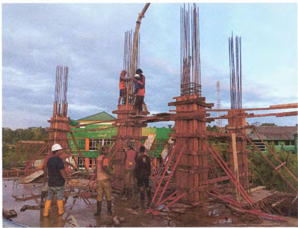
Pekerjaan Pengecoran Kolom
