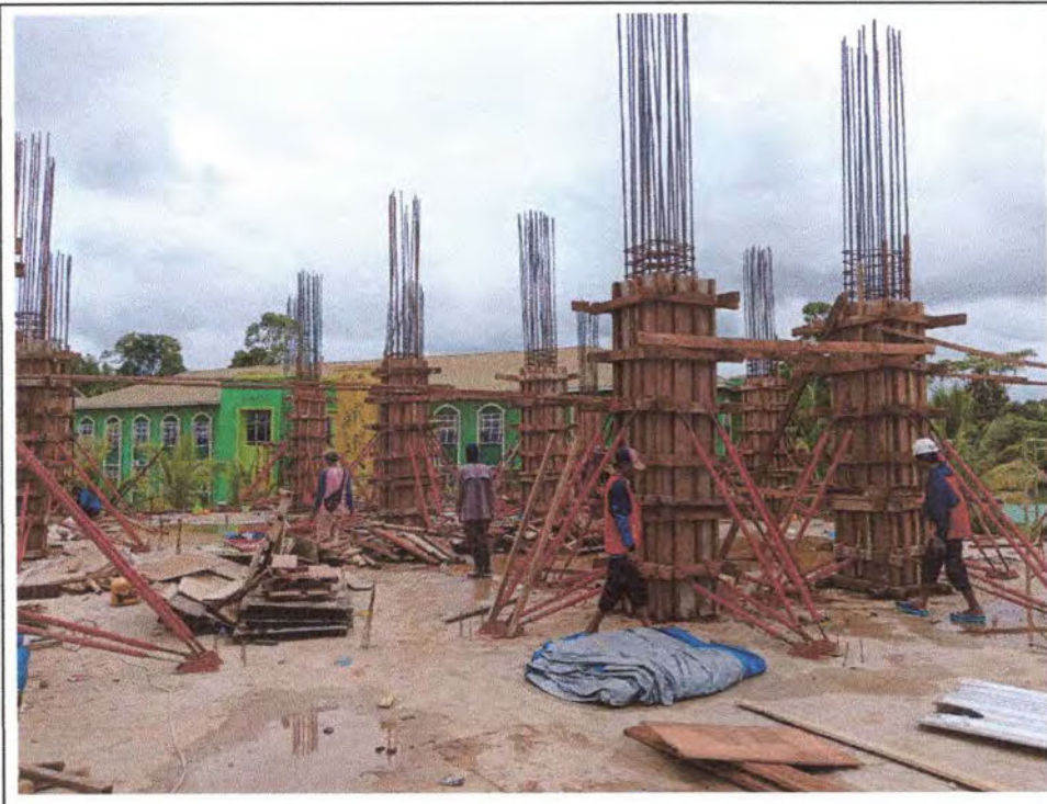
Pekerjaan Pemasangan Bekisting Kolom
