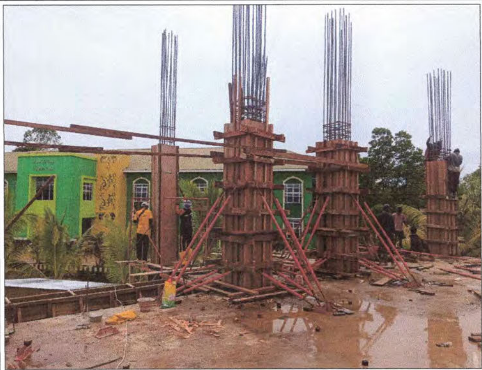
Pekerjaan Pemasangan Bekisting Kolom
